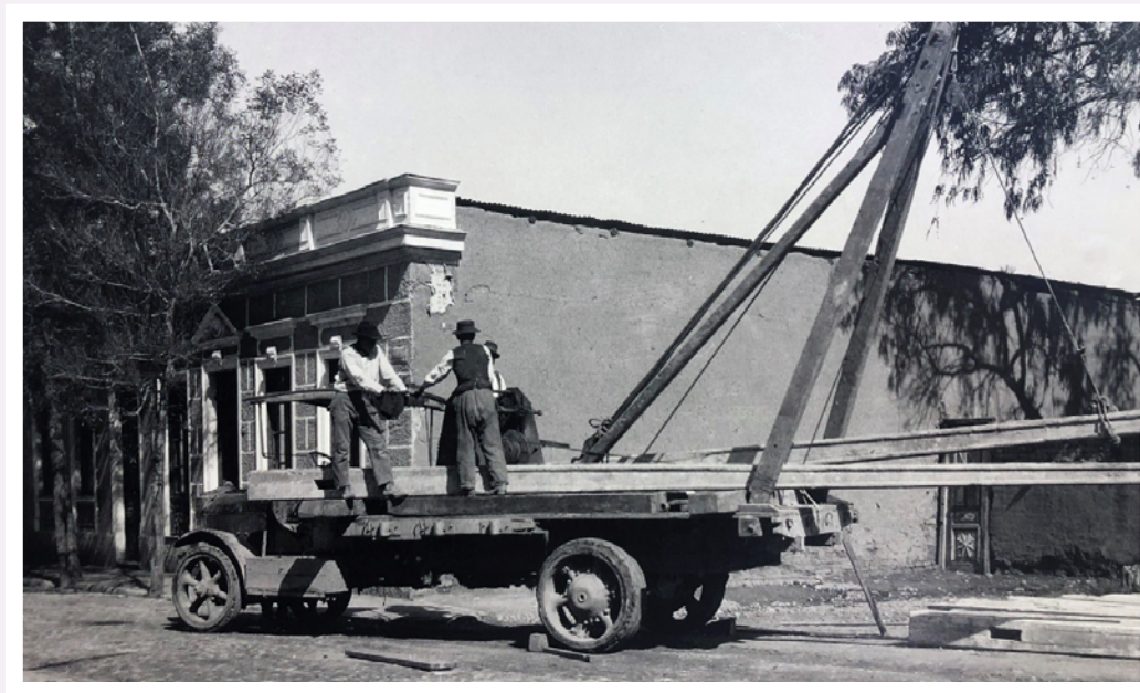
FIGURA 2 Postes alumbrado eléctrico. Centro de Santiago. Sin fecha. Fuente: Archivo Fotográfico ENEL Distribución.
