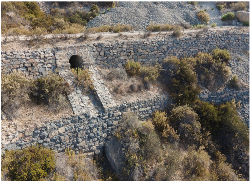
FIGURA 4. Obras civiles en sector Puentes del mineral de Tamaya. Fuente: Campos et al., Fragmentos, 2023.
