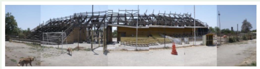
FIGURA 11 Fotografía tribuna Estadio Ferroviario previo a su destrucción. 2012. Studiopanorama. Josef Dubernig.
