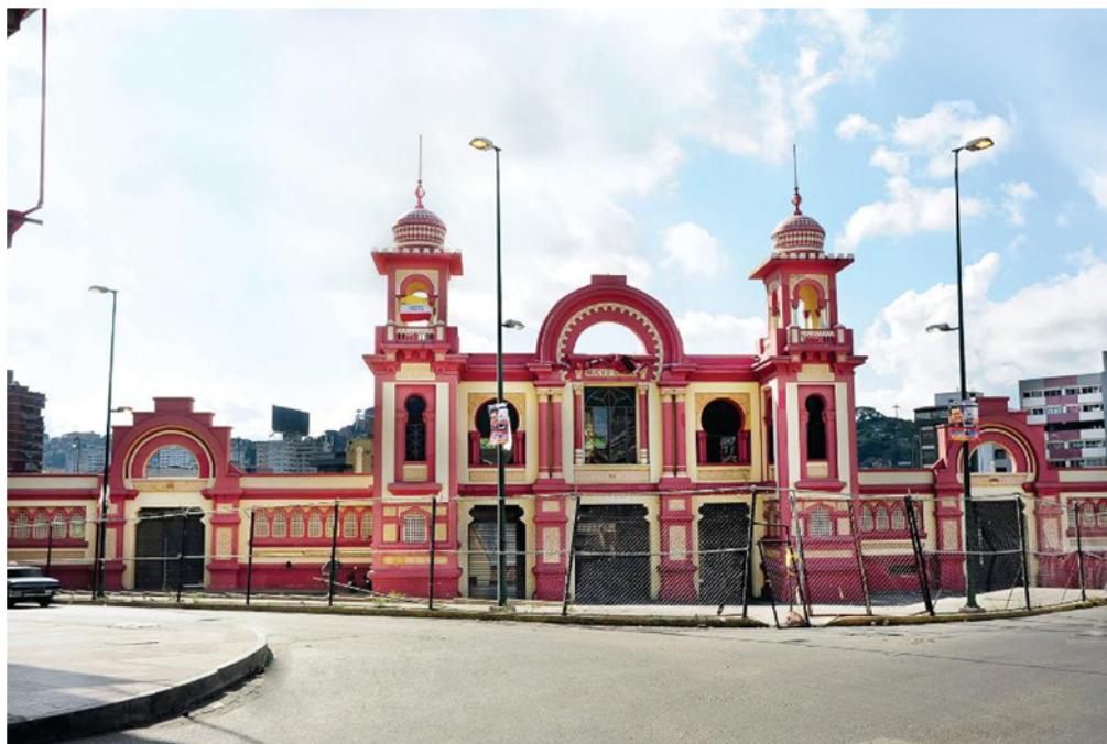
FIGURA 13 Alejandro Chataing y Luis Muñoz Tébar, Nuevo Circo de Caracas (fachada), 1919, Caracas del valle al mar ( https://guiacccs.com/obras/nuevo-circo/ ).
