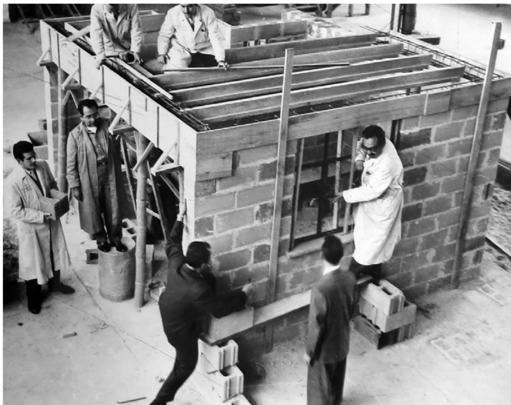
FIGURA 8 Prototipo del departamento de costo limitado construido en los talleres del CINVA. Fuente: CINVA, "Departamento de costo limitado (1957)", 60.
