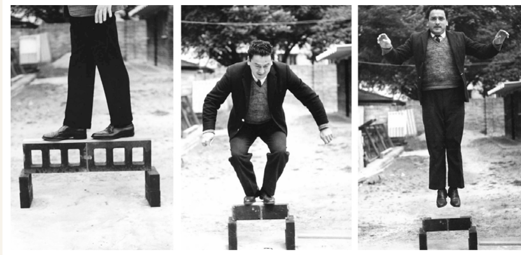
FIGURA 9 Pruebas de carga sobre dinteles elaborados con ladrillos y morteros de la ESSO Research and Engineering Company. Fuente: Enteiche, "Informe Programa No. 1 de la investigación CINVA ESSO (1964)", 44-45.
