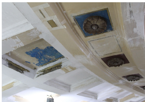
FIGURA 18 Trabajos de limpieza y descubrimiento de pigmentos originales de la cúpula. Azul y dorado son los tonos principales que se repiten en diferentes elementos ornamentales, mobiliario, cortinas, etc. En la imagen se puede ver el detalle de casetón que revela la existencia de policromías originales en estos tonos. FIGURA 19 Detalle de cinta dorada (policromía) en bordes de cenefa interior de cúpula y casetón con borde dorado con trampa. Fuente: Archivo de la obra
