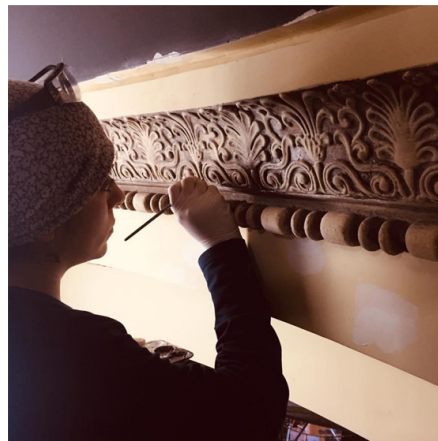
FIGURA 24 Limpieza de pan de oro en ornamentos de la cúpula. FIGURA 25 Reintegración en ornamentos de la cúpula. Fuente: Archivo de la obra.
