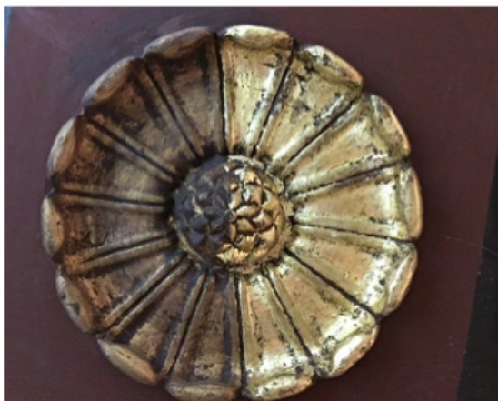
FIGURA 24 Limpieza de pan de oro en ornamentos de la cúpula. FIGURA 25 Reintegración en ornamentos de la cúpula. Fuente: Archivo de la obra.
