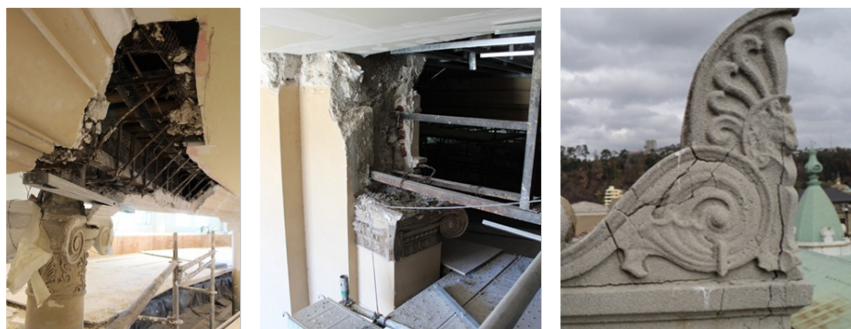
FIGURA 2 Daños de cornisa en la galería. FIGURA 3 Daños visibles en pilares. FIGURA 4 Daños en ornamento exterior. Fuente: autores del proyecto
